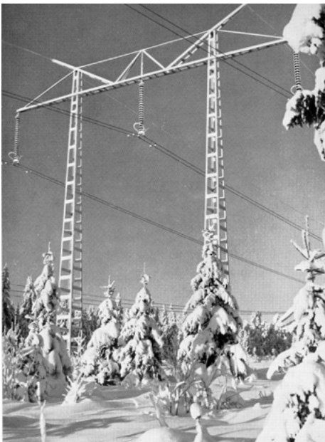
The first 400 kV line Harsprånget-Midskog-Hallsberg. Photo: Hitachi Energy
