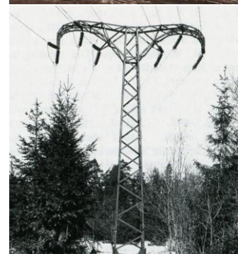
Underst Kraftledningen Untra - Stockholm 2*100 kV
