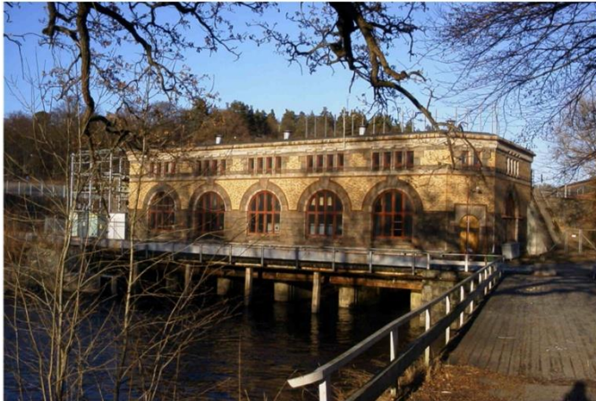
Jonsereds kraftstation byggd 1901
