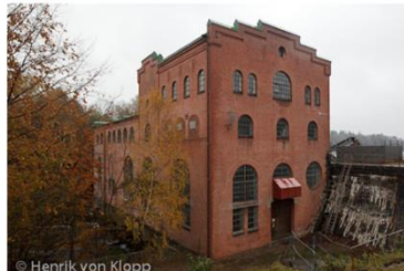
Bassalt kraftverk i Lagan invigt 1910, 8 MW
